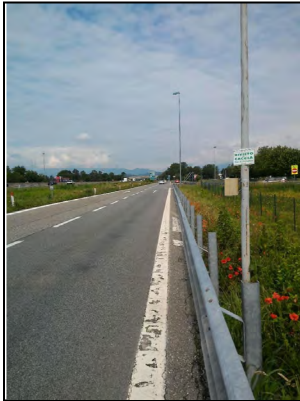
Postazione vista in direzione futura rotatoria
