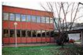
Nuovo Centro Civico Pozzo Strada in Torino
