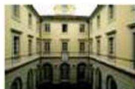
Regio Manicomio di Via Giulio in Torino – Ristrutturazione e Restauro conservativo
