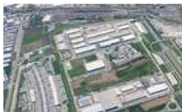
SITO : Interporto di Torino Infrastrutture varie
