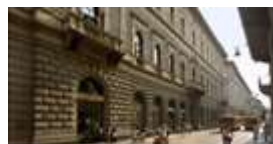
Palazzo Turati in Milano ristrutturazione e restauro
